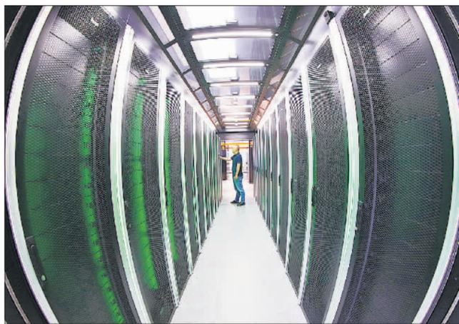
绿色节能低碳技术应用。部分智算中心采用液冷、高压离心式变频水冷、封闭冷通道等先进制冷技术,使得机房散热能耗降低50%以上,PUE值降至1.2以下,节约空调电费超过50%,提高服务器算力5%~10%。部
