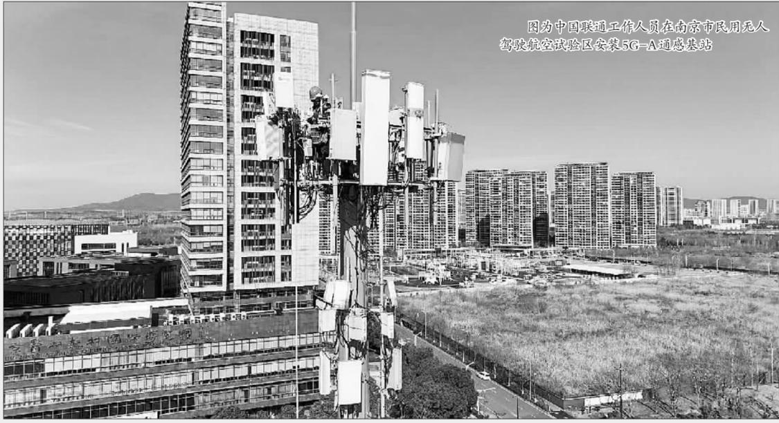
图为中国联通工作人员在南京市民用无人驾驶航空试验区安装5G-A通感基站
