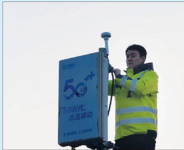
图为中国移动网络保障人员正在调整应急通信车上的5G基站设备
