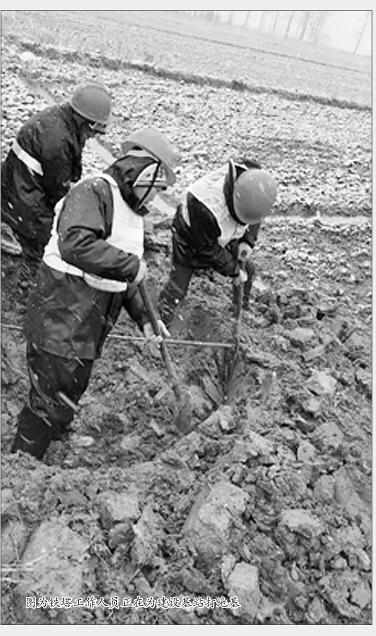
图为铁塔工作人员正在为建设基站打地基
